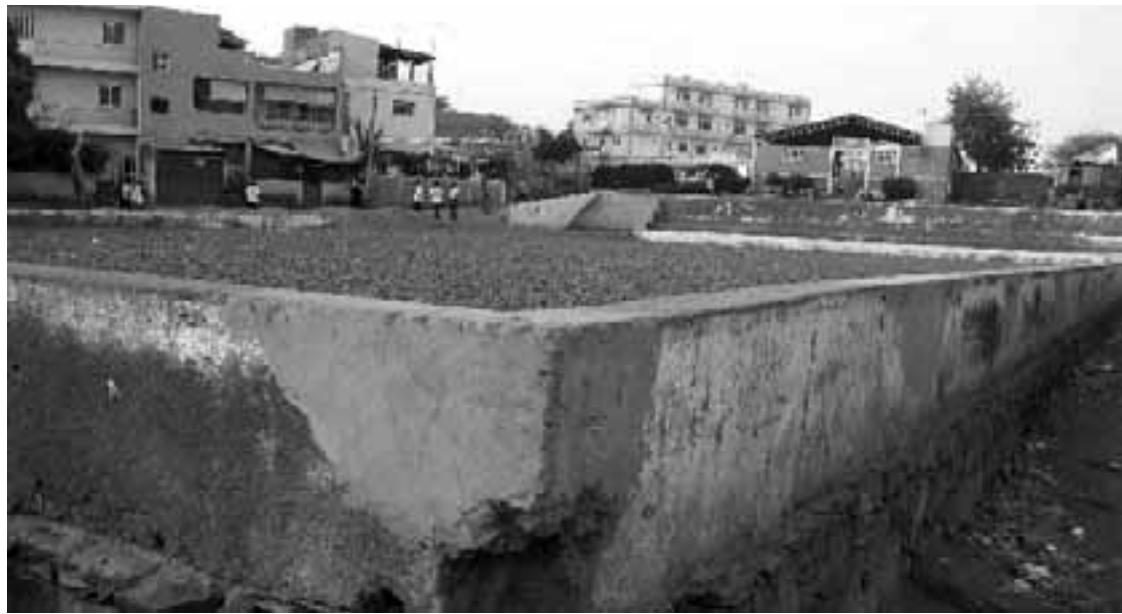
A placa desportiva transformada em depósito de jorra
