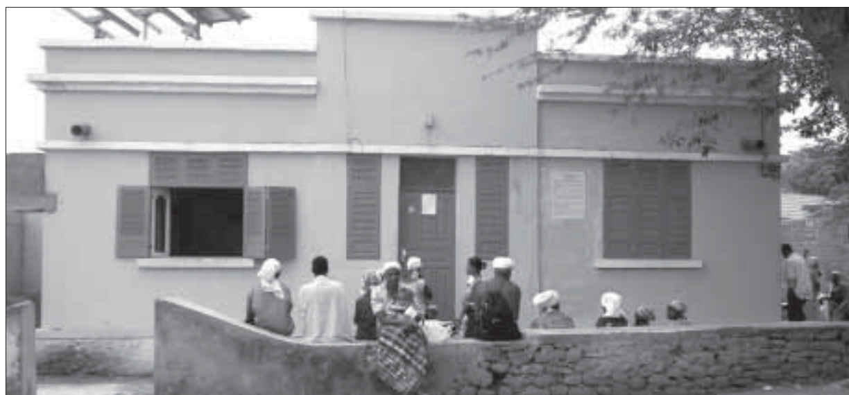
POSTO SANITÁRIO DE CALHETA SÃO MIGUEL
